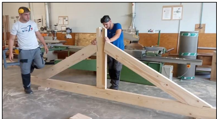
Assemblage de la ferme
