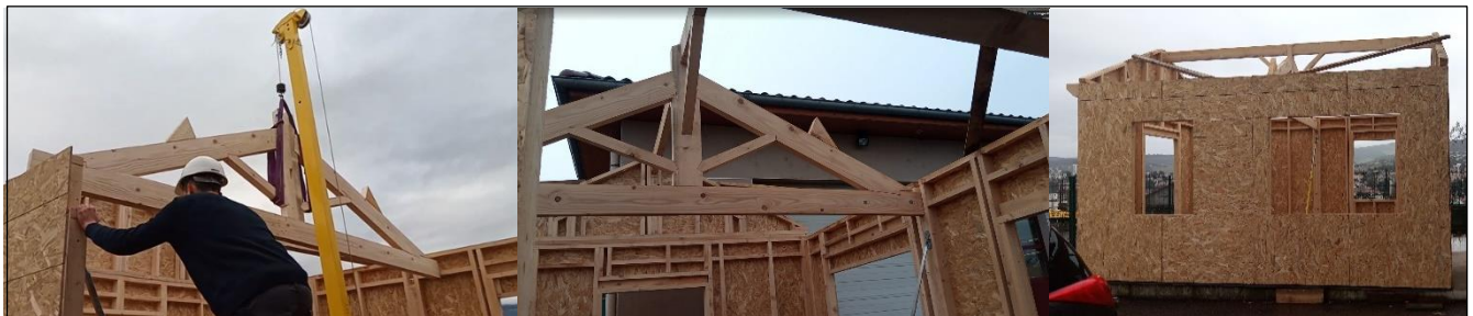
Levage de la charpente
