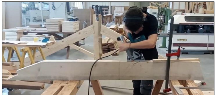
Assemblage de l'arbalétrier
