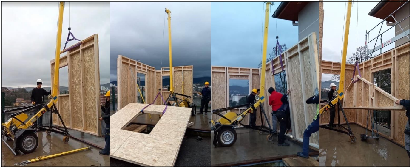
Levage des murs ossature bois du rdc
